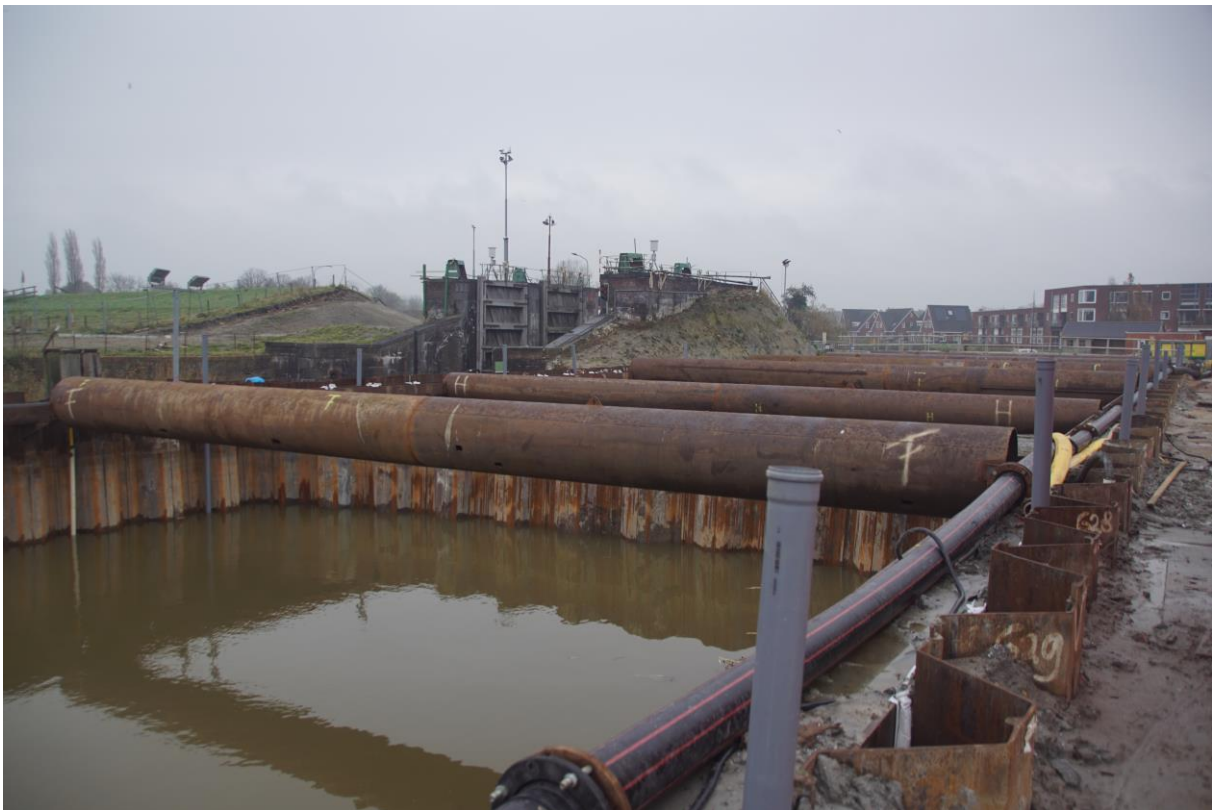
(bouwput van het nieuwe gemaal Hunsingo in Zoutkamp, gezien vanaf de kant van het Zoutkamperril; afb.ve)
