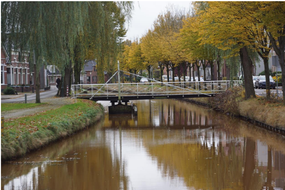
Lubbermansdraai over het Pekelerhoofddeep (afb. ve).
