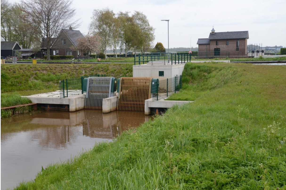
Gemaal van de Polder Wetering na recente uitbreiding, (afb. ve)
