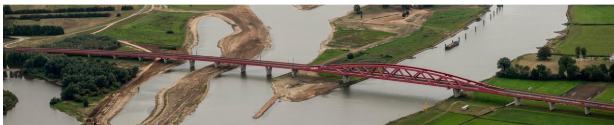
Afbeelding: Waterschap Drents Overijsselse Delta, spoorbrug bij Zwolle over de IJssel.
