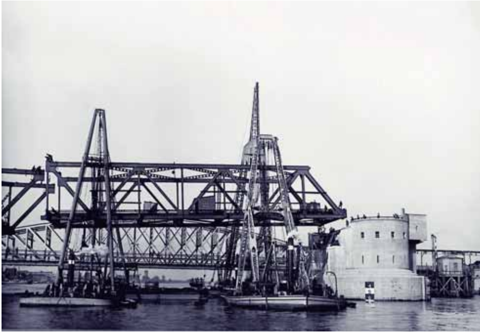
Afb. 2. Een ingevaren overspanning voor de brug bij Zaltbommel wordt gemonteerd (uit: De Ingenieur (1939), p. B 46, figuur 8).
