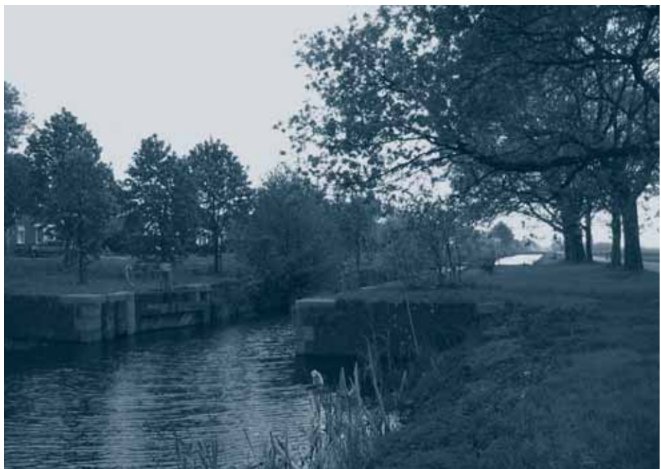
Afb. 1. De te restaureren sluis in het Verlengde Oosterdiep bij Barger-Compasuum (foto Waterschap Hunze en Aa's).
