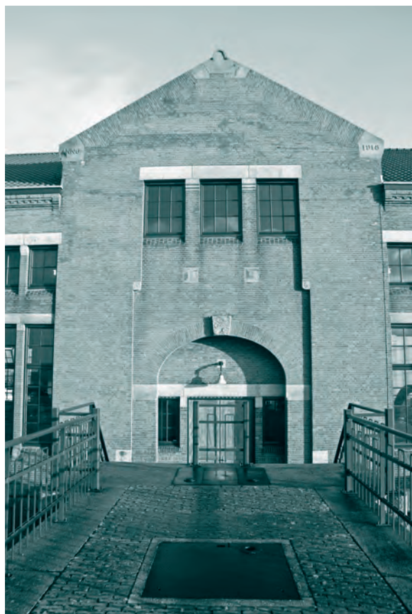
Afb. 5. Uitgang zeezijde, sluitstenen boven de deur en jaartal in de topgevel. Foto auteur.
