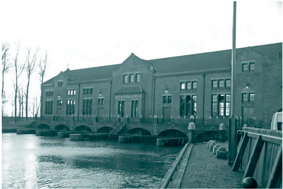
Afb. 1. Gemaalgebouw (machinehal) boezemzijde. Foto auteur.
