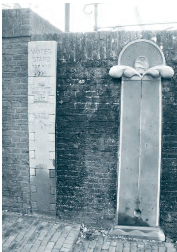
Afb. 2. Hoogwatermerken in de Waterpoort in de Lekdijk te Wijk bij Duurstede. Foto auteur.
