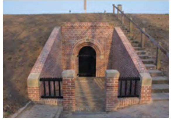
Afb. 6. Het magazijn na de voltooiing van de restauratie. Foto G. Bouma, Stichting Waterschapserfgoed.
