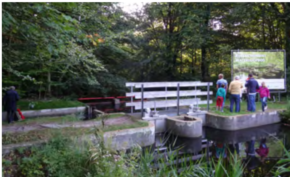
Afb. 2. De gerestaurerde Romijnstuw in het Waterloopbos. Foto ir. G.J. Arends.
