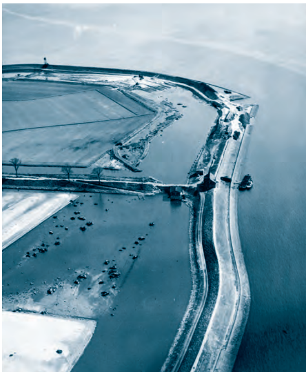
Afb. 1 Dijk van het Waterschap Poortvliet, Tholen. In het midden het poldergemeentje, daarachter de bergboezem met uitwateringssluis. Foto Afdeling Multimedia Rijkswaterstaat (beeldbank.rws.nl).
