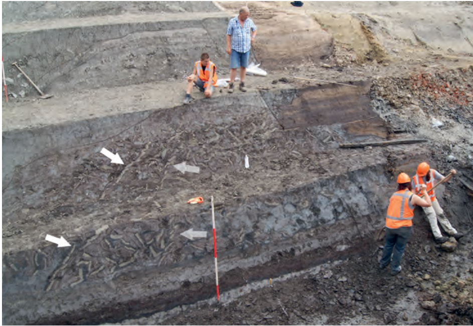
De opgegraven dijk met netjes gestapelde zoden. Foto uit besproken rapport 'Wonen aan een wiel'.
