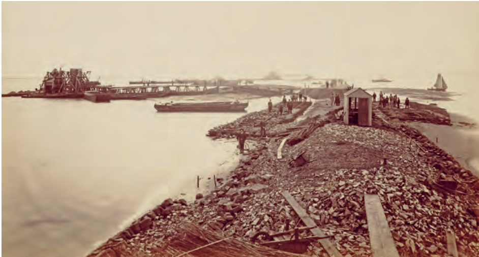
Afb. 6 Foto van de firma P. Oosterhuis van de strekdam in aanleg op 28 april 1892. Op de voorgrond een zinkstuk dat alsnog werd toegepast nadat de stroming de opgeperste berm had weggespoeld. Aan de horizon ligt links het Vuurtoreneiland. Stadsarchief Amsterdam.
