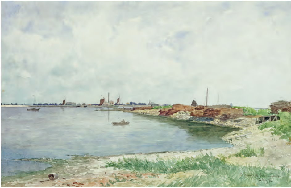
Afb. 4 Johan Conrad Greive (1837-1891) zat in augustus 1872 op de Paardenhoek de Afsluitdijk in wording te tekenen. Het rijshout in het sluitgat was twee maanden eerder boven water gekomen. De zeilschepen op de achtergrond bevinden zich in de Oranjesluisen. Aan de horizon zijn de kerktorens van Durgerdam en Ransdorp zichtbaar. Beeldbank Stadsarchief Amsterdam, 010097015339.
