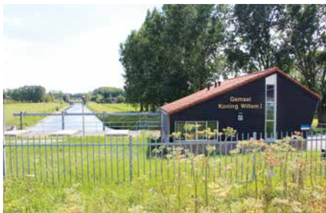
Afb. 9 Twee recente gemalen die het overtollige water vanuit de Haarlemmermeerpolder op de Ringvaart uitslaan. Het gemaal Koning Willem I (links) is tegenwoordig het hoofdgemaal en het gemaal Bolstra (rechts) bemaalt speciaal het gebied van Schiphol. Foto's Bart Schultz.
