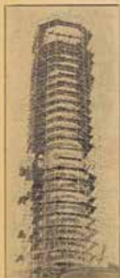
De eerste bruggen van de landaanwinning verheffingen in Oostende, die de bestaande schiedingen zal overwinnen, is in aanbouw.
