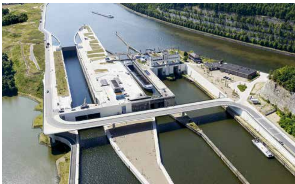
Afb. 10 De vierde sluis van Ternaaien is bijna gereed. Foto Bureau Greisch ( www.greisch.com/projet/quatrieme_ecluse_lanaye/ ).
