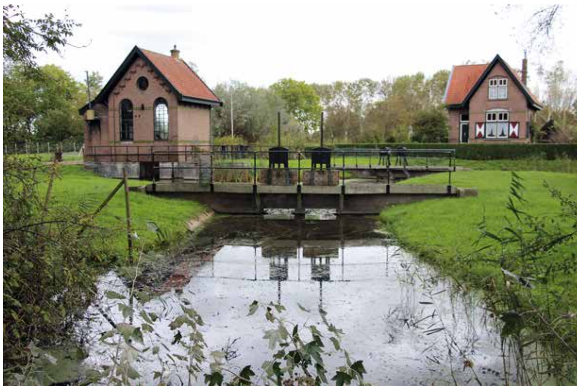
Afb. 8 Gemaal Velserbroek met rechts de Oostlaandersluis. Foto Bart Schultz.
